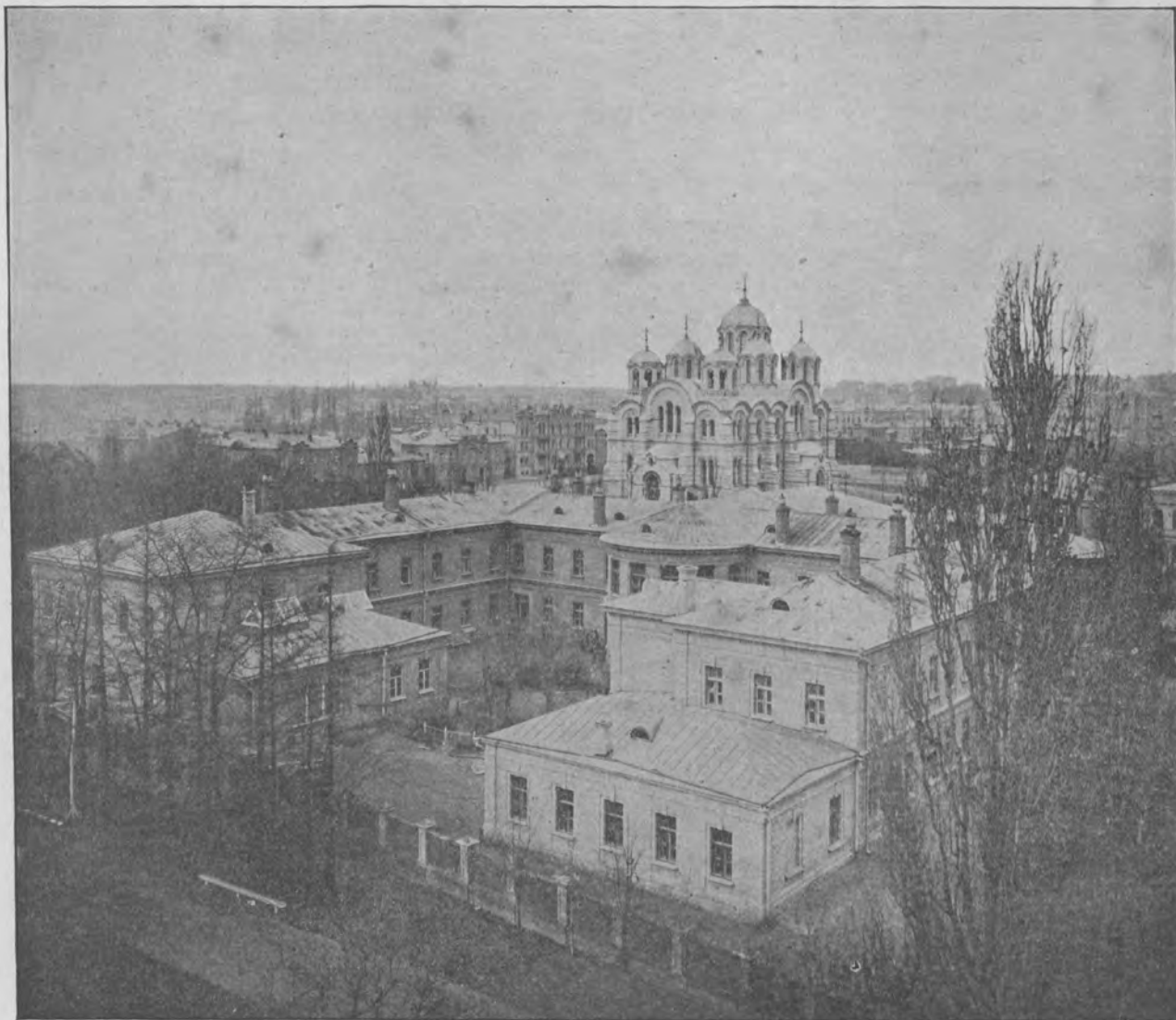
Фиг. 7. Видъ клиники 1900 г. сзади и сверху, съ крыши университетскаго зданія, со всѣми пристройками.
