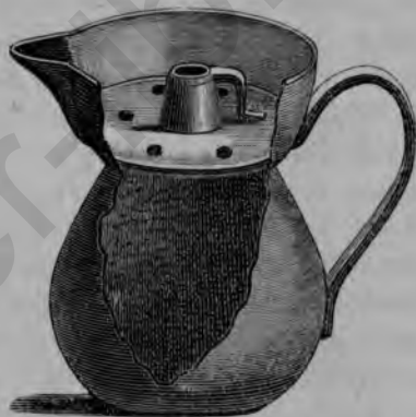
Рис. 222. Одинъ изъ образцовъ глинянаго кипятивника для молока, работы финляндскихъ гончарныхъ заводовъ.
