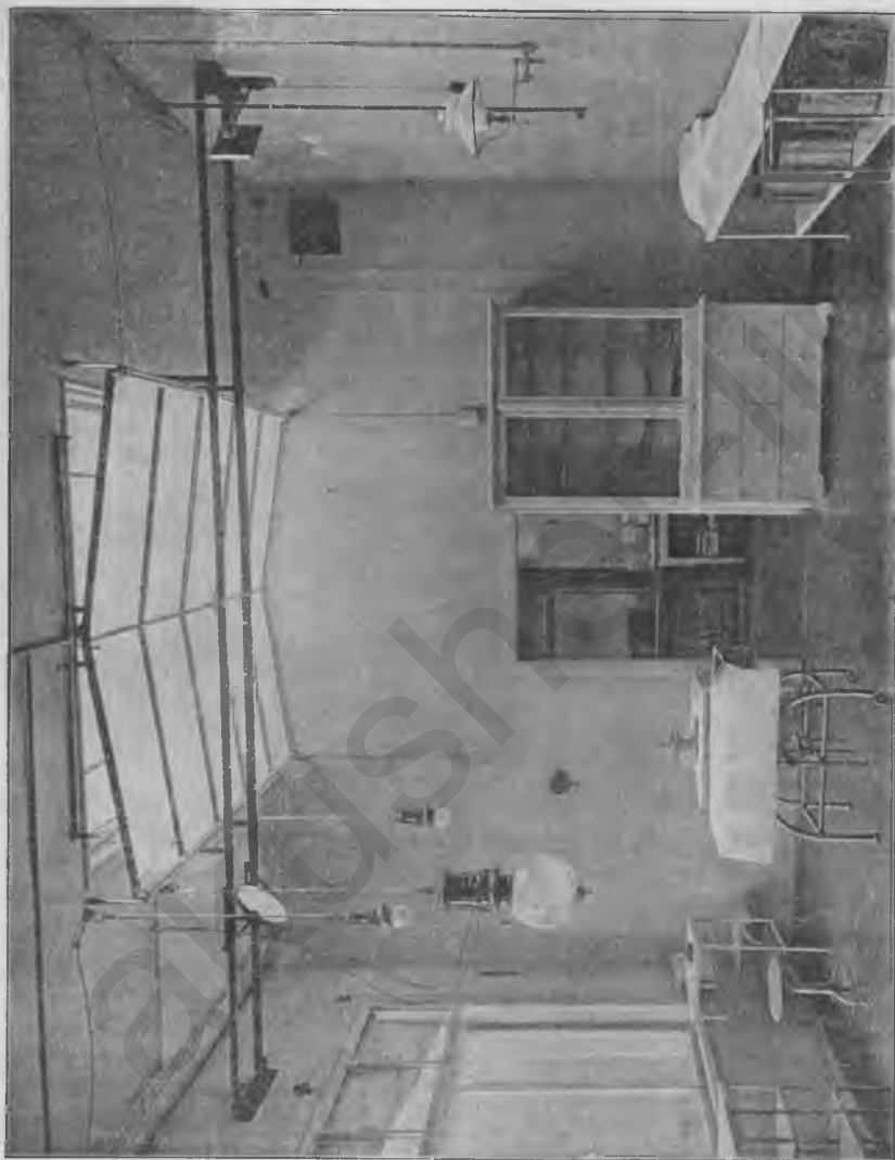
Рис. 16. Рисунокъ представляетъ операціонную и показываетъ, что пространство, занимаемое рельсами и зеркалами, очень невелико. Освѣжительный приборъ вследствие простоты его конструкции не служитъ ловушкой для пыли. Рельсы придѣланы высоко. При измѣненіи болѣе горизонтально падающихъ свѣтовыхъ лучей рекомендуется болѣе длиннымъ шнуромъ удалять проекціонное зеркало отъ рельса и тѣмъ приближать къ операціонному столу до 1,5 метра.
